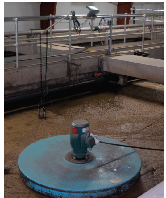
Abbildung 1: Anoxische Zone mit schwimmendem Mischer (TriOxmatic®, VARION® und SensoLyt® Sensoren im Hintergrund)
